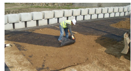
그림 14. 5호 보강토옹벽 곡선부 그리드 시공
