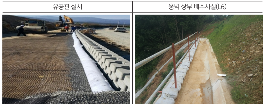
그림 11. 5호 보강토옹벽 배수시설 설치
