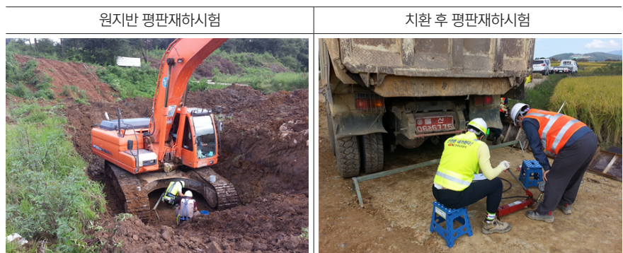
그림 8. 5호 보강토 옹벽 기초지반 치환
