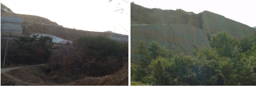
그림 2. 전체 보강토옹벽의 붕괴사례 및 발생원인
